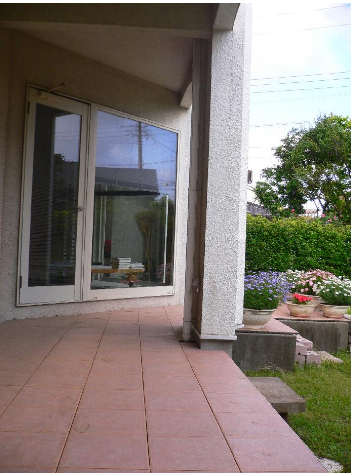
1Fデッキへの張り出し部右側
