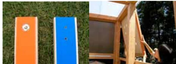
図13「固定用マジックテープ」、図14「パネル装着状況」
