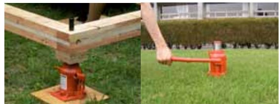
図7「ダルマ型ジャッキによる基礎代行と水平出し」、図8「手作業による高さ調整」
