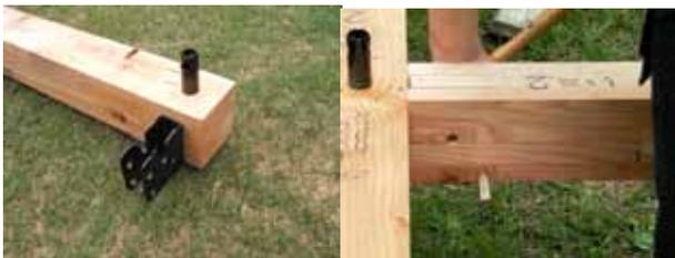
図10「あご掛金物」、図11「ホールダウンパイプとピン」
